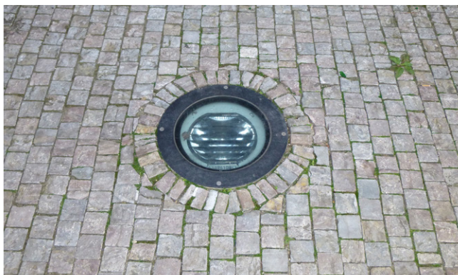
Obr. 52: Protioslňující clony pozemních svítidel
