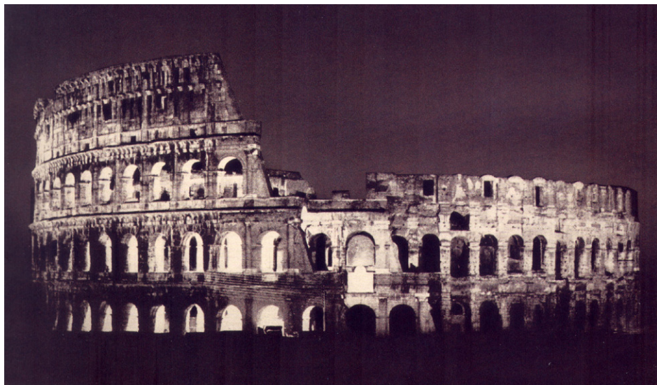
Obr. 51: První slavnostní elektrické osvětlení Colossea, Řím, 1930
