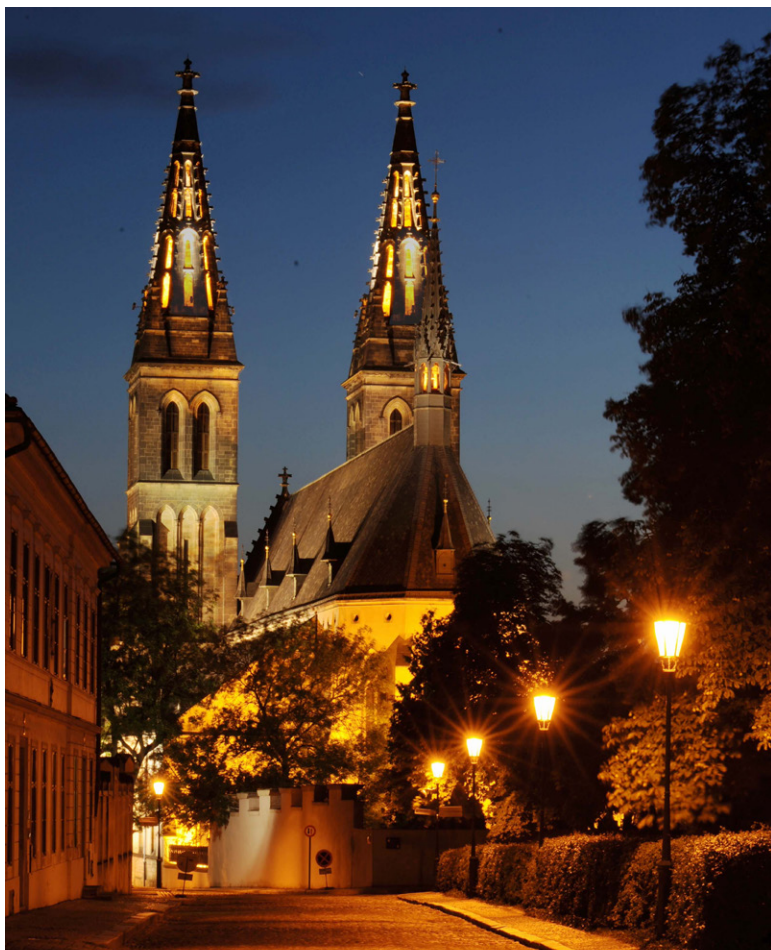
Obr. 70: Osvětlení kostela sv. Petra a Pavla na Vyšehradě
