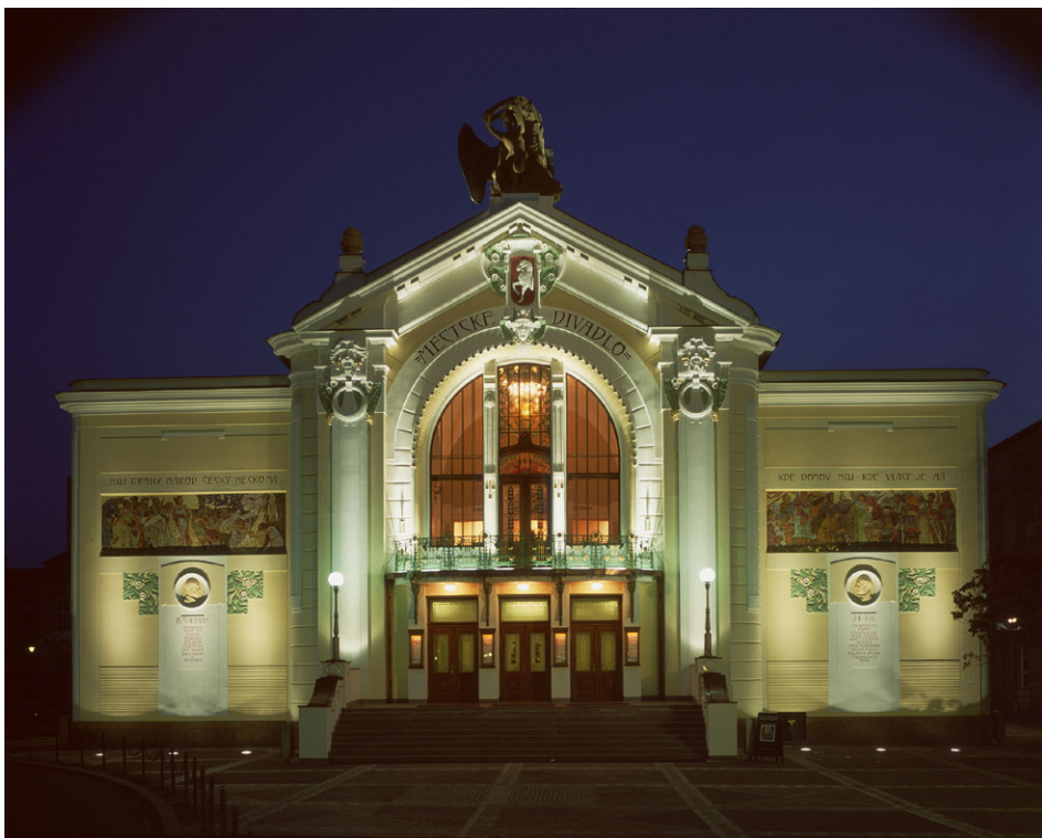
Obr. 66: Osvětlení fasády divadla v Pardubicích
