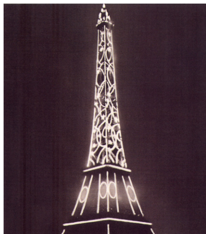
Obr. 47: Osvětlení zdůrazňující kontury ocelové konstrukce věže (druhý stupeň osvětlení), 1925)
