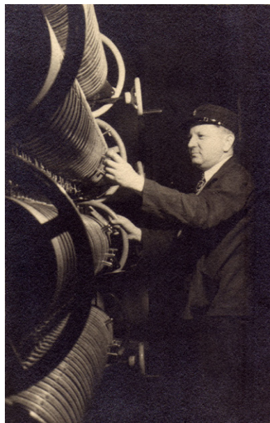
Obr. 25: Osvětlovač při práci s otočnými reostaty, Národní divadlo, Praha
